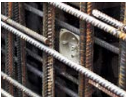
Крышка KBV, прикрепленная на опалубке.
