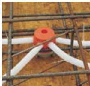
Пример установки в горизонтальной опалубке.
