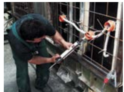
Герметизация вводов (отверстий).
