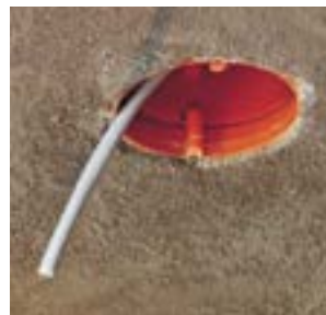
Коробка KBV... с выведенным проводом, готова для установки люстрового крюка KBP...
