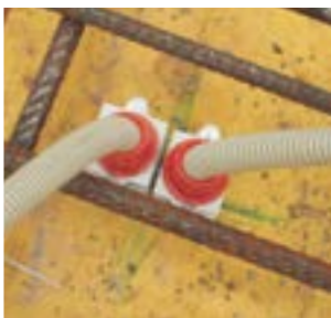
Пример использования концевых втулок и муфт.
