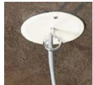
Коробка KBV... закрытая крышкой V 68 S с выведенным проводом и люстровым крюком KBP...
