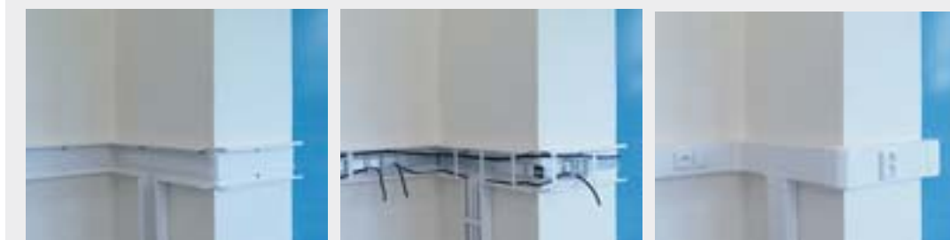
Установка кабель-каналов Элегант ЕКЕ.
